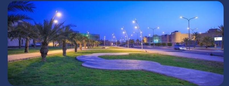
أعمال الطرق بحديقة الإسكان النسائية بريدة Road works in the women's housing park in Buraidah
