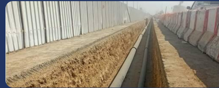
إنشاء شبكة مياه بمحافظة عنيزة Establishing a water network in Onaizah Governorate
