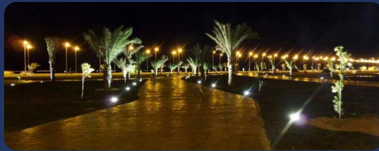
أعمال الإنارة بالكورنيش الجنوبي بشاطئ السيف بمدينة جدة Lighting works, the southern corniche, Al-Seef Beach Jeddah
