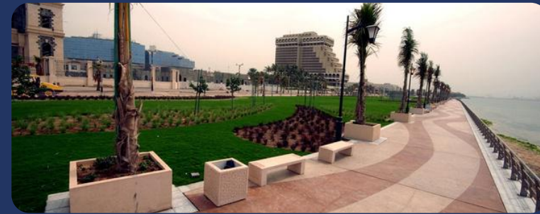
أعمال الإنارة بالكورنيش الأوسط وممشي فلسطين بمدينة جدة Lighting works in the central corniche and Palestine Walk in Jeddah
